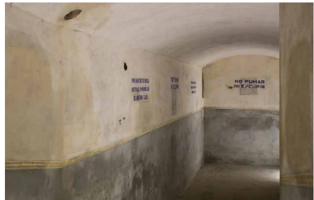
Vista del refugi de la fàbrica Bombas Gens.
